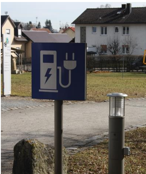
Abbildung 5: Ladestation für Elektromobile (Schukostecker)
