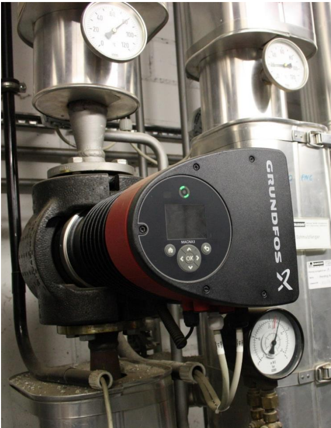
Abbildung 4: Eine der modernen geregelten und damit energiesparenden Umwälzpumpen
